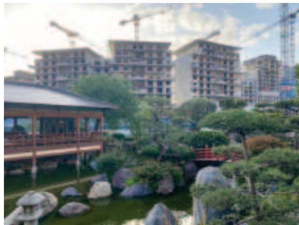
（既存庭園周辺のコンドミニアム建築の様子）
